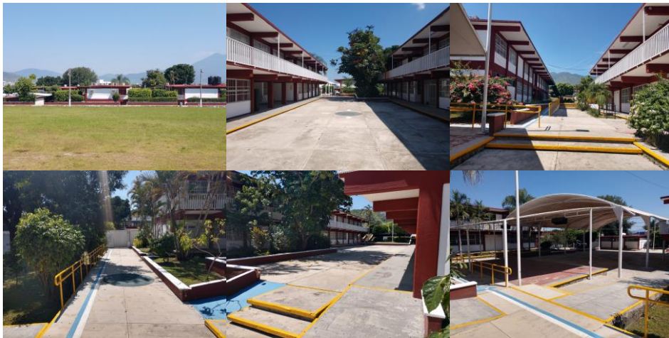
Figura 4. Instalaciones del Cetus 100.
